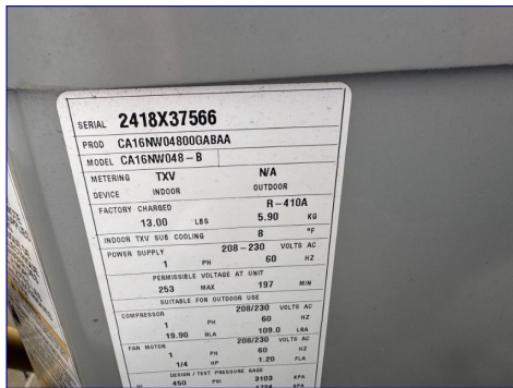
AC condenser data plate.
